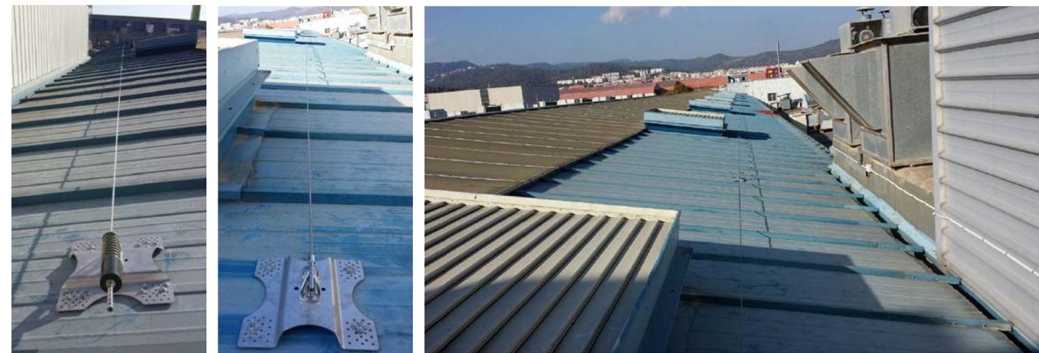
IMATGES DETALL FIXACIÓ LÍNIA DE VIDA
